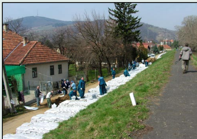
Mentett oldali töltés homokzsákos megtámasztása az áprilisi árvíz idején
