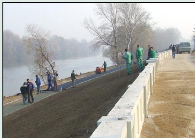
Utolsó tisztítások a felújított védtöltésen
